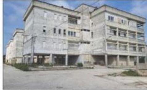
Gli immobili da demolire e ricostruire in via Lamarmora
